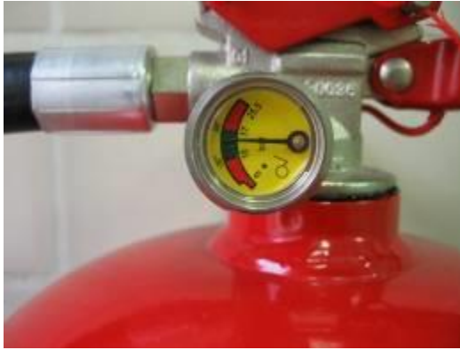
2.6. ábra Nyomásmérő a készenlétkben tarthatóság ellenőrzésére
