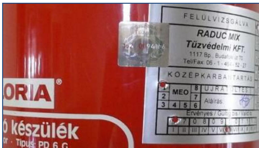
2.15. ábra Felülvizsgálatot igazoló címke az OKF hologramos azonosítóval együtt érvényes
