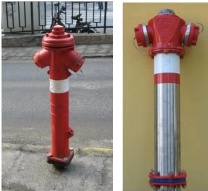
Hagyományos öntöttvas, és új korrózióálló-acél anyagú föld feletti tűzcsapok szabályos megjelöléssel
